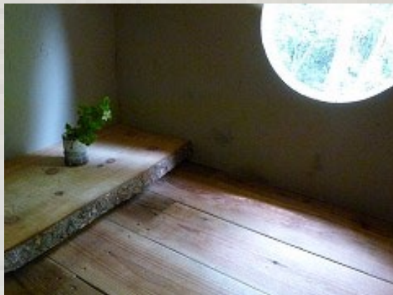
気持ちの良い杉の足場板のままの床。床の間は樺の木、皮付きのまま。 丸窓は、あえて平滑ガラスで、まるでガラスがないかのように。光を計算 した窓からは床の間の花活けに微妙な光が遊ぶ。
